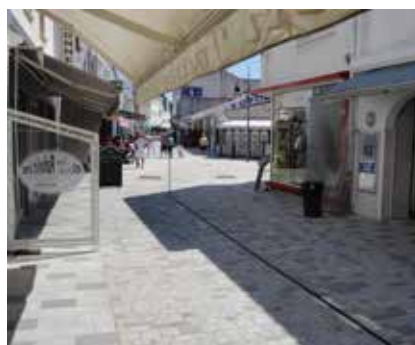
Aménagement Grand Rue, Noirmoutier
