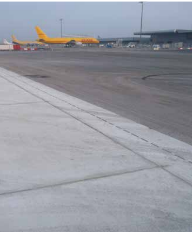
Aéroport de Lyon, St Exupéry
