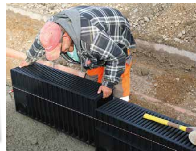
Mise en oeuvre rapide
