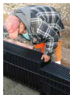
Mise en oeuvre rapide
