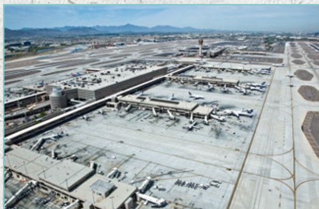
Beton ist ein dichter Werkstoff und wird deshalb für die Hauptflächen in unserer heutigen Verkehrs- infrastruktur (Straßen, Flughäfen, WHG-Flächen, LAU-Anlagen ...) eingesetzt.
