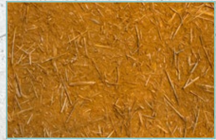
Mit Pflanzenfasern bewehrte Lehmwand.
