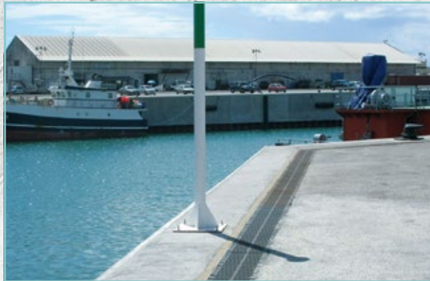
Einsatz in korrosiver Umgebung am Meer.
