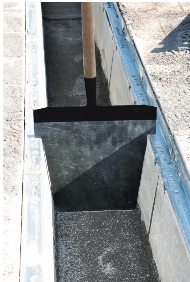
Abb.: Zugscharre zum Abziehen des Substrates (hier mit DRAINFIX CLEAN FSU)
