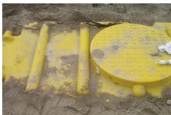
Separatori a coalescenza con raccolta fanghi SKPE 10/1000, piazzale del magazzino di un'impresa, Modena
