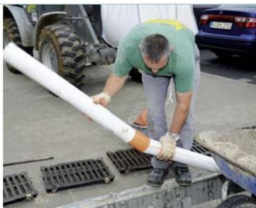
I tubi di drenaggio devono essere inseriti prima dell'aggiunta del substrato.
